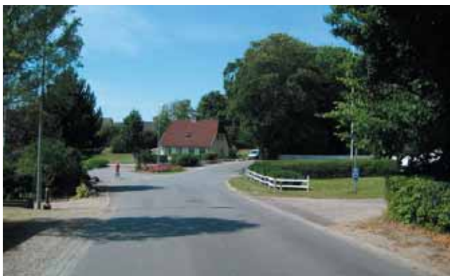
Hjarup Byvej: Til højre i billedet ses den problematiske indkørsel til vejen/cykelstien som fører til tunnellen under Koldingvej og videre til Forbundsskolen i Skanderup.
