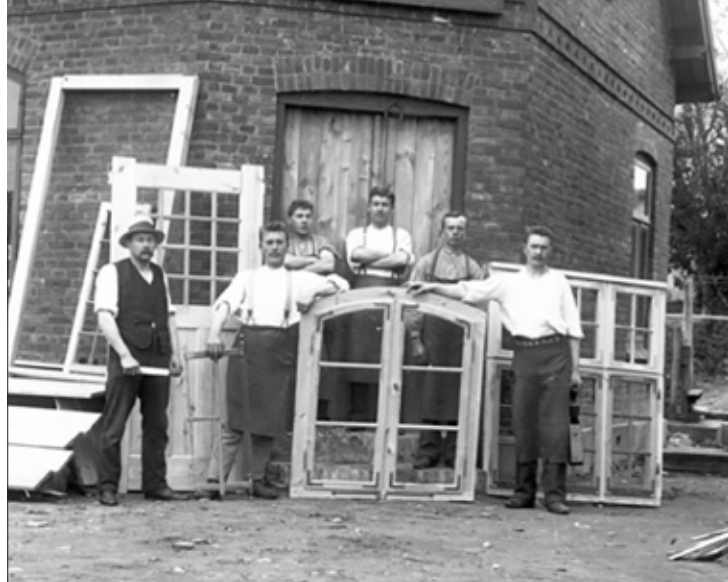
Her er en flok snedkere, som stolt viser vinduesrammer frem.
